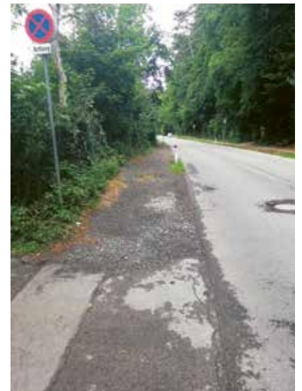
Hier wird ein Gehsteig errichtet
