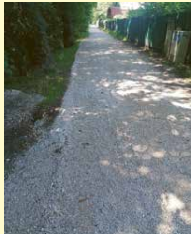
Schotter unbefestigt auf der verlängerte Wienzeile
